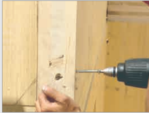
Conexión angular entre dos paredes de un edificio de madera con tornillos HBS
