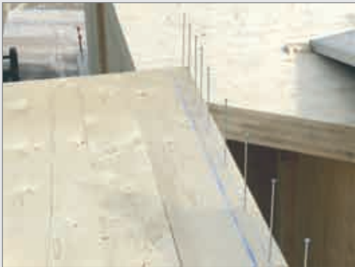
Conexión techo-pared de un edificio de madera
